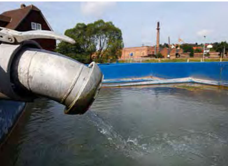
Vor der Einleitung in die Losse werden aus der Brunnengalerie Losseaue in Absetzbehältern die Schwebstoffe aus dem Wasser abgeschieden.
