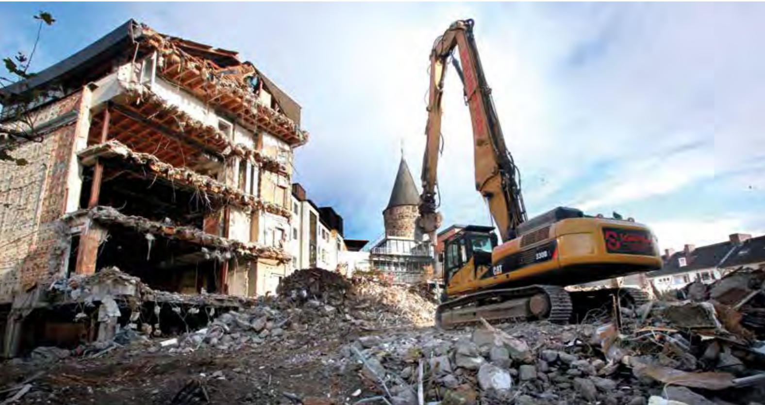
Qualifizierter Rückbau statt Abriss: Auch als das Kasseler Traditionshaus Overmeyer am Königsplatz einem Neubau wich, ging es streng nach dem neuen Kreislaufwirtschaftsgesetz zu, über dessen Einhaltung im RP Kassel gewacht wird. Der Bauschutt, auf dem sich hier noch der Bagger bewegt, ging anschließend zur endgültigen Aufbereitung. Foto: HNA/Herzog
