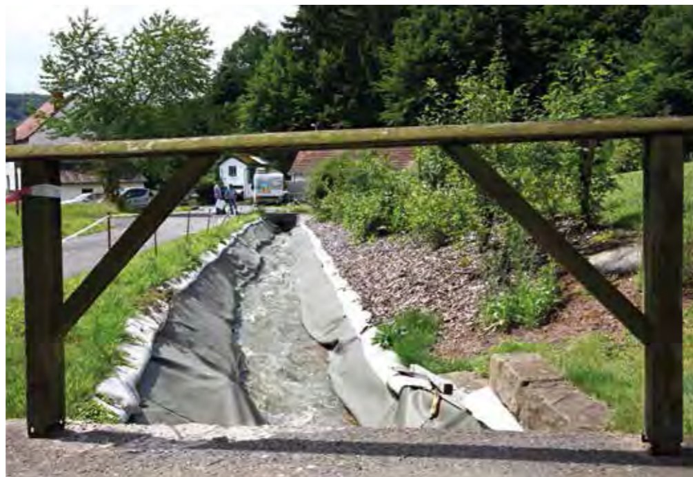
Der vollständig mit Folie ausgelegte Weißbach in Küchen. Sauerlich waren die Folien auch um Baumstämme gespannt und geklebt worden, damit alles anschließend schnell wieder in seinen ursprünglichen Zustand zurückversetzt werden konnte. Foto: Andreas Fischer
