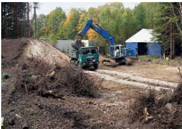
Abb. 5.26: Wallabtrag Areal 14a (Keplerstraße)
