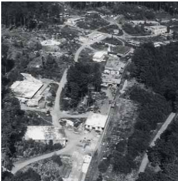
Abb. 1.2: Füllstelle West nach Demontage und Sprengung
