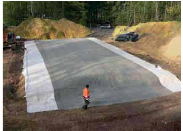
Abb. 5.17: Einbau einer Bentonitmatte, Waschhaus 339 (Ecke Liebigstraße / Gutenbergstraße)
