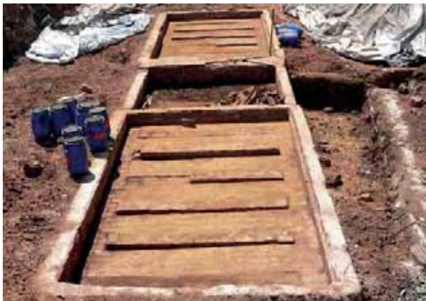
Abb. 5.19: Sanierung Areal 9a Waschhaus 309 (Ecke Liebigstraße / Gutenbergstraße)
