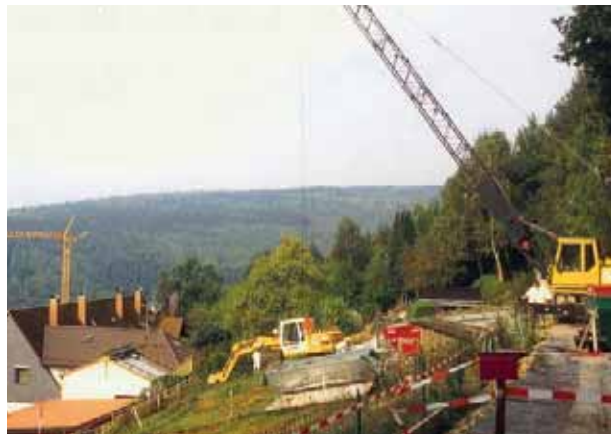
Abb. 5.20: Sanierung im Bereich der Siedlung Waldhof
