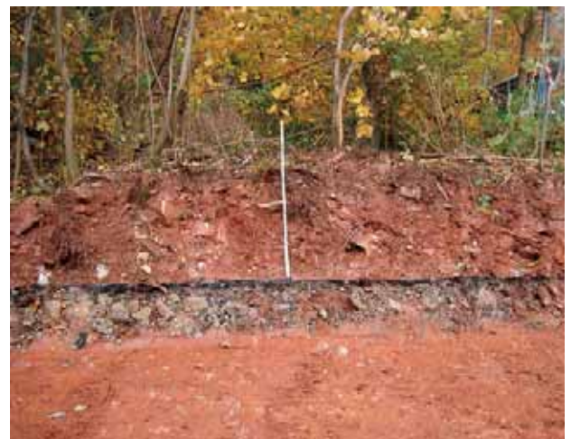
Abb. 2.17: Aufbau eines Teerweges
