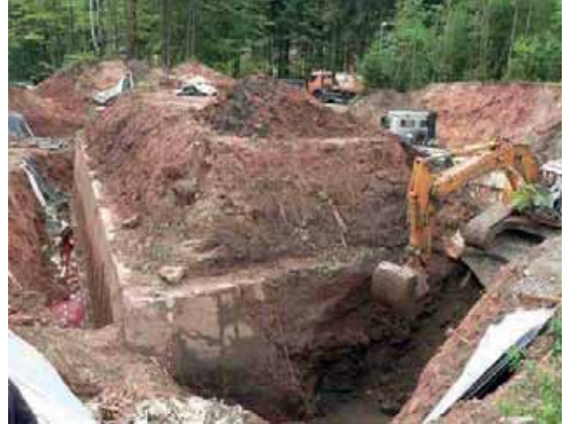
Abb. 5.16: Sanierung Areal 9a Waschhaus 339 (Ecke Liebigstraße / Gutenbergstraße)
