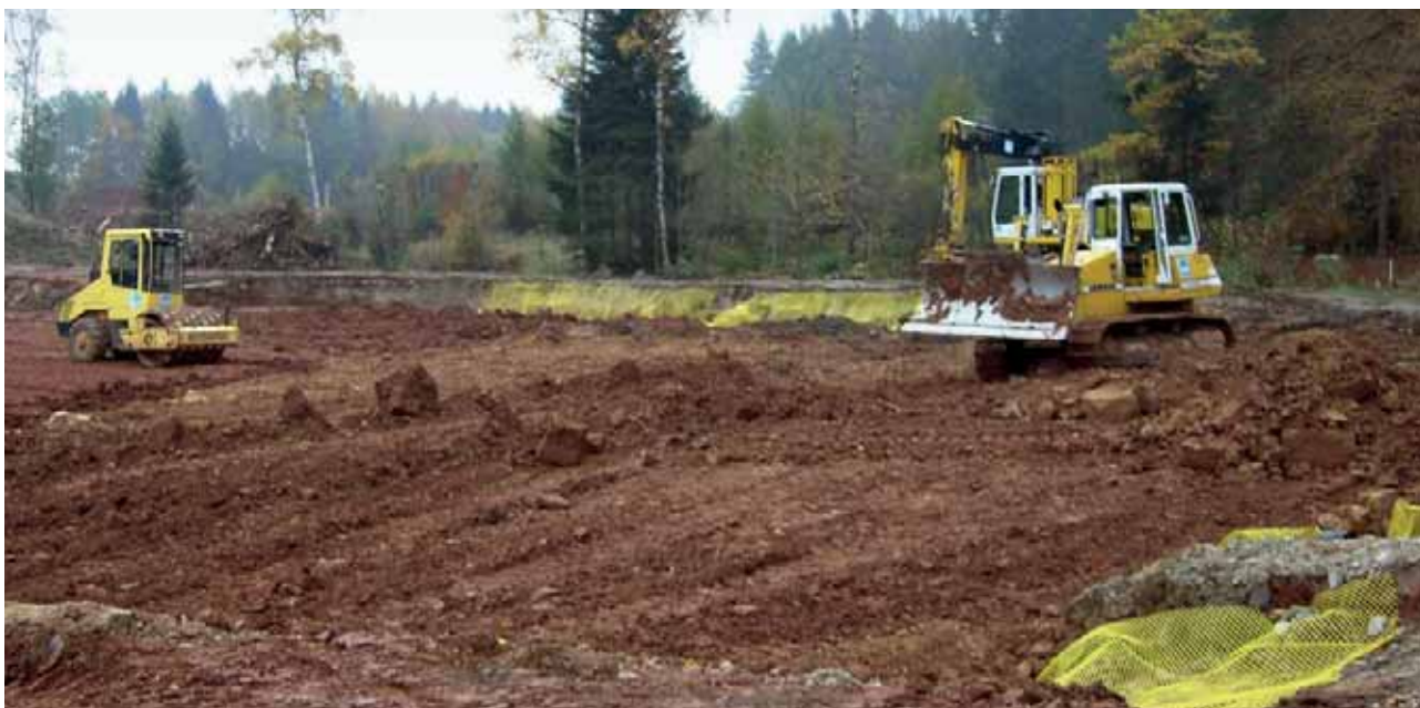
Abb. 5.43: Einbau von Rückbauboden
