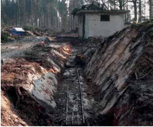
Abb. 5.9: Leitungsfunde im Areal 8 (Monolager, Kreuzungsbereich Dieselstraße / ehem. Bahntrasse)
