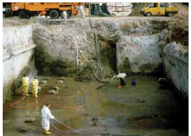
Abb. 5.18: Sanierung Waschhaus 329 (Daimlerstraße)
