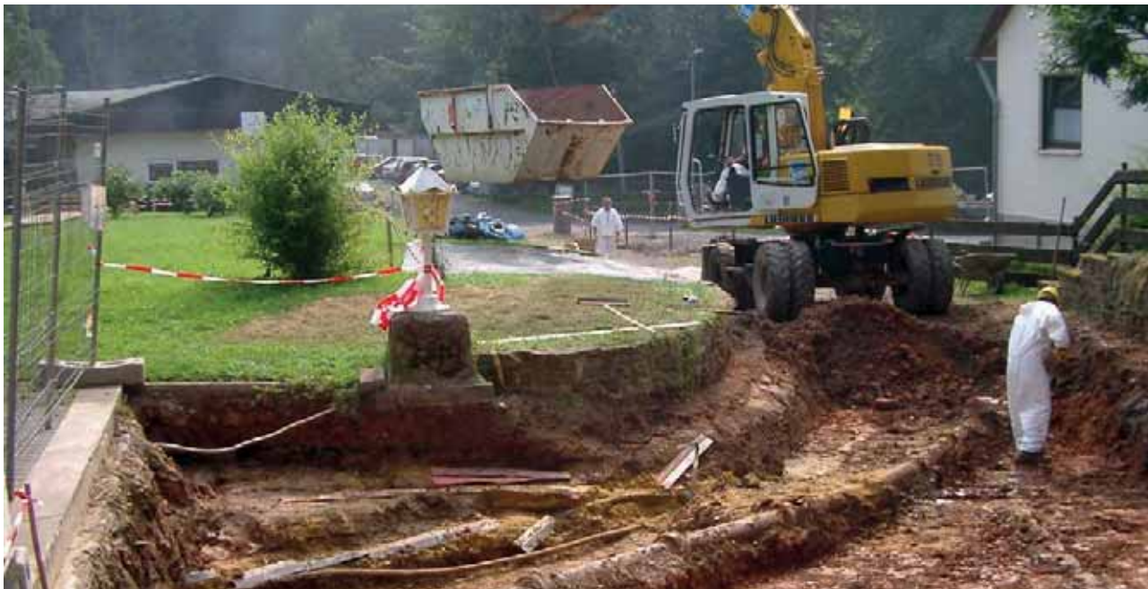
Abb. 5.8: Sanierung Gartengrundstück, Gutenbergstraße
