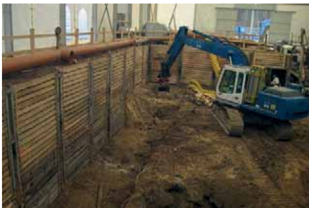
Abb. 5.27: Einhausung / Spundwände Areal 14 a
