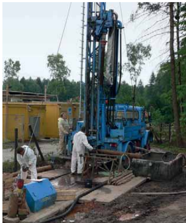
Abb. 2.13: Errichtung einer Grundwassermessstelle
