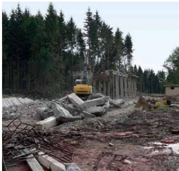
Abb. 5.12: Gebäudeabriss Areal 8 (Entladestation für Kesselwagen, Kreuzungsbereich Dieselstraße / ehem. Bahntrasse)
