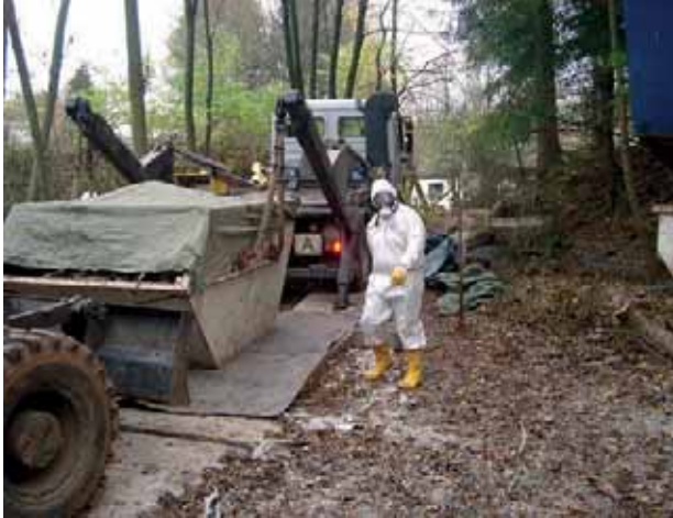
Abb. 5.13: Übergabestation Schwarz- / Weißbereich
