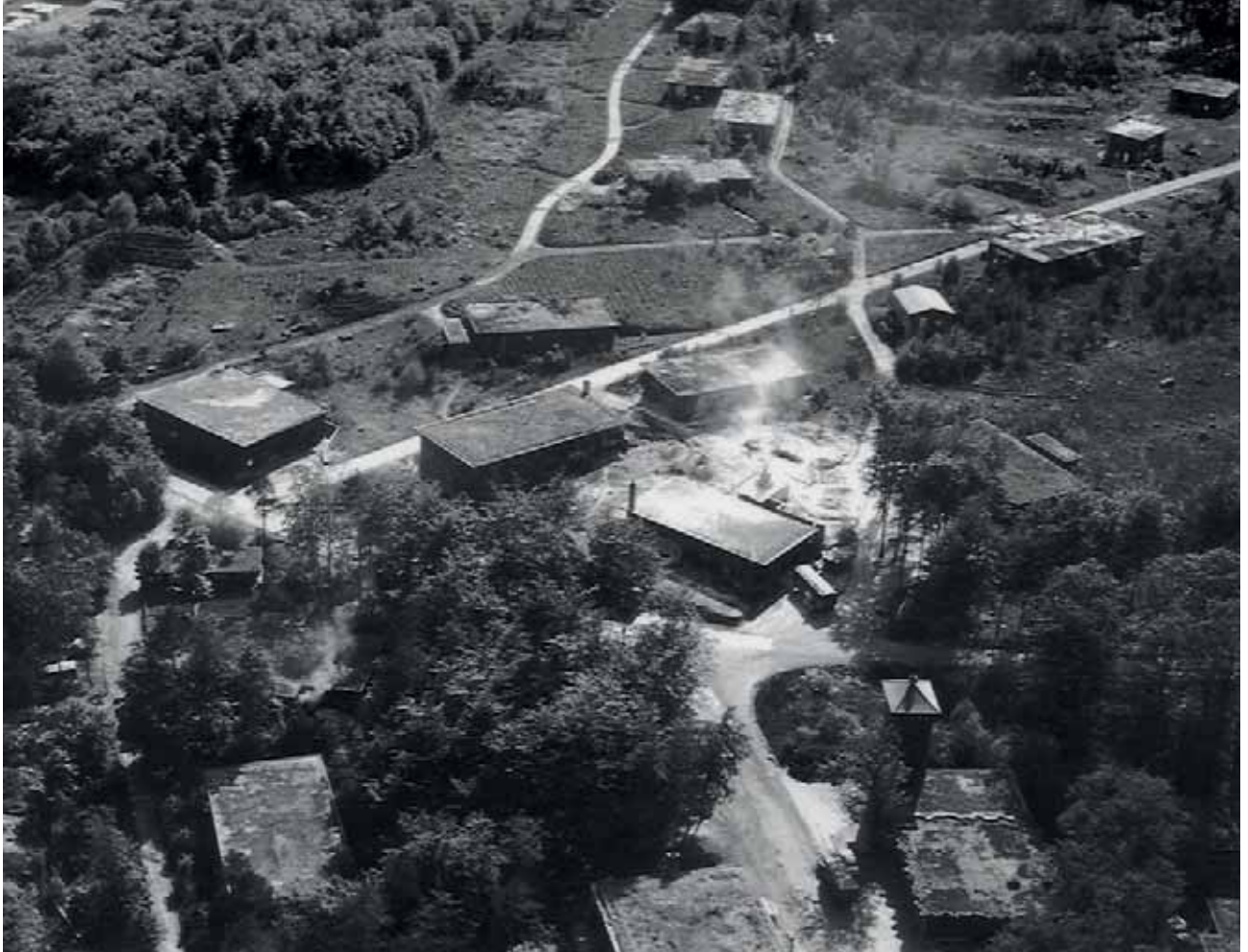
Abb. 1.3: Blick über die Daimlerstraße (Mitte) auf die eingeebneten Pressengebäude
