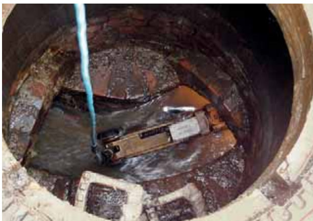
Abb. 5.52: Einstieg in Schacht zur Kanalerkundung
