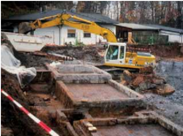
Abb. 5.14: Sanierung Waschhaus 309 (Abwasserschikanen, Daimlerstraße gegenüber Einmündung Keplerstraße)
