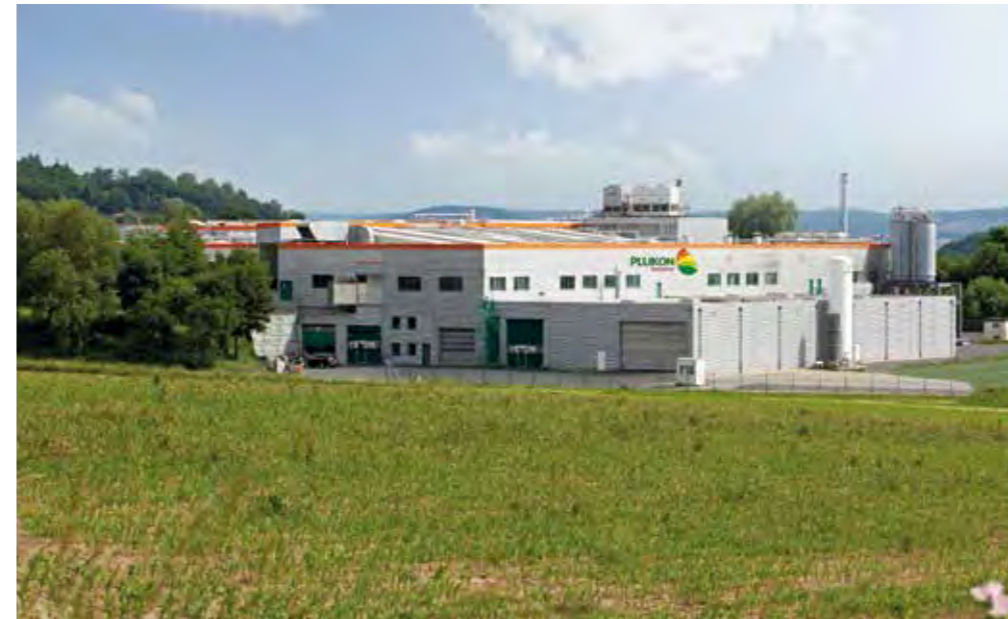
Vor der Modernisierung und Erweiterung: der Betrieb der Plukon Gudensberg GmbH. Die Kapazitäten von Schlachtbetrieb, Fleischverarbeitung und der Abfallverwertung sollen künftig verdoppelt werden. Eine neue Abluftreinigung soll eine mögliche Geruchsbelästigung in der Umgebung verhindern. Anfang Juni erhielt das Unternehmen für das Gesamtvorhaben die Genehmigung aus dem Regierungspräsidium. Foto: Plukon Gudensberg GmbH
