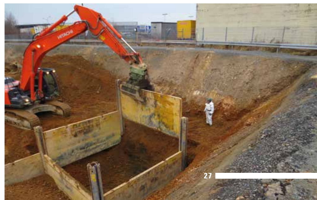
Nachdem das Gelände acht Meter tief ausgekoffert war, wurden auf dem Grund sogenannte Verbaukästen eingesetzt. Sie dienen dazu, das kontaminierte Erdreich für Quadrant auszuheben. Es wurde vor Ort gereinigt und wieder eingebaut. 2.800 LKW-Fahrten konnten so eingespart werden. Foto: CDM Smith Consult GmbH, Niederlassung Bingen
